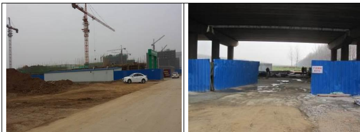
图 7.1-1 施工期围挡措施
